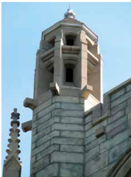
Les pierres disposées autour des clochetons de l'église Saint-Alphonse-d'Youville attendent toujours d'être sculptées.
