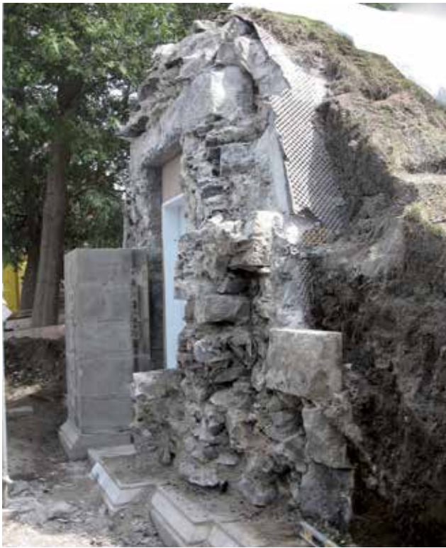
Le mausolée d'Honoré Mercier, pendant et après les travaux Photo : Jean-Philippe Servant, CCNQ
