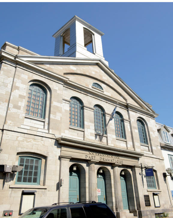
L'aspect extérieur de la chapelle Trinity of Ease n'a pas beaucoup changé malgré sa transformation pour accueillir le Théâtre du Conservatoire d'art dramatique de Québec. Photo : Laurent Généreux
