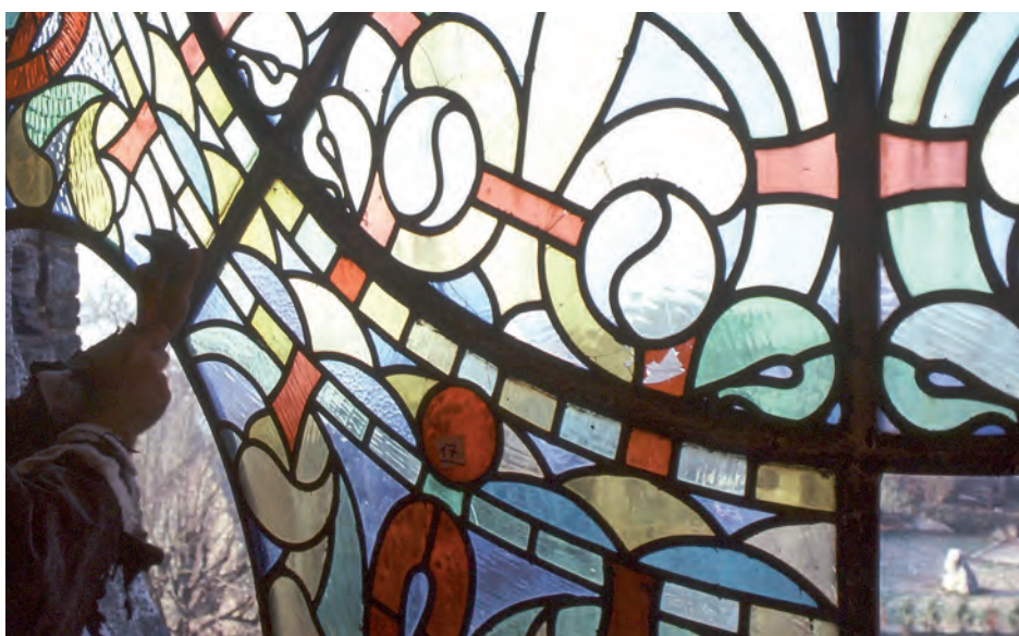
Un artisan procède à la dépose d'un vitrail installé dans une rosace. Une opération qui demande beaucoup de doigté !
