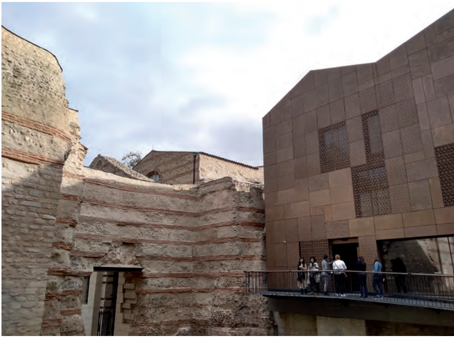
Au Musée de Cluny, à Paris, le nouveau pavillon d'accueil, conçu par l'architecte Bernard Desmoulin, dialogue avec les ruines des thermes du Nord de Lutèce et l'hôtel des abbés de Cluny.
