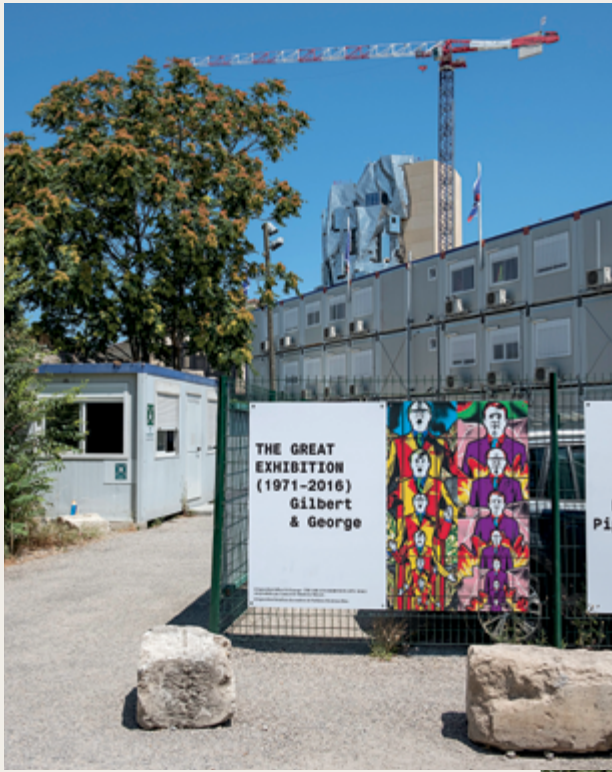
Site de la Fondation Luma, avec le nouveau bâtiment de Frank Gehry en construction / Site of Luma Foundation with Frank Gehry's building under construction photos : Bruno Chalifour
