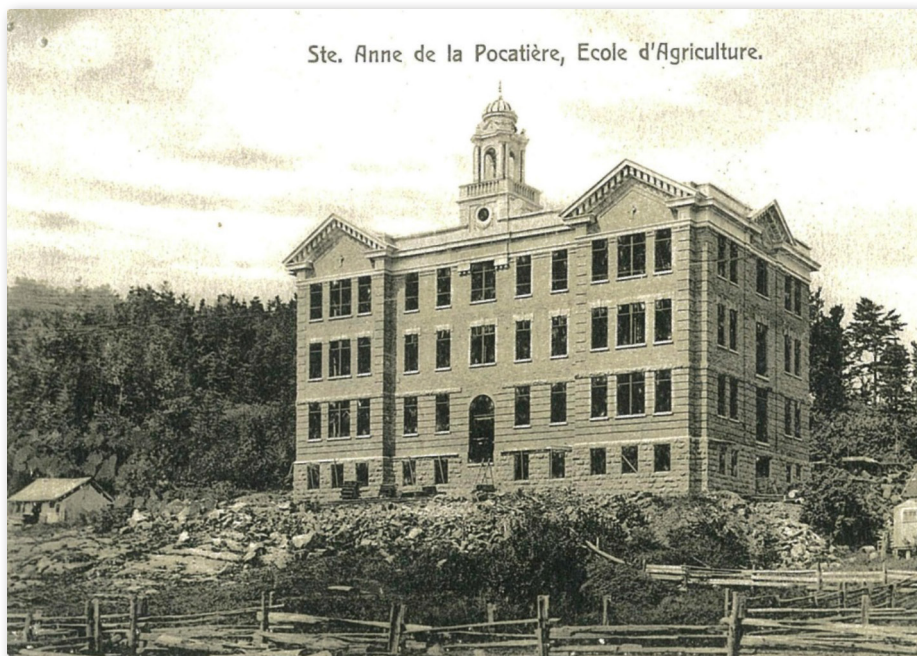
Construction de l'École d'agriculture, vers 1911. (Source : ITA Campus de La Pocatière)
