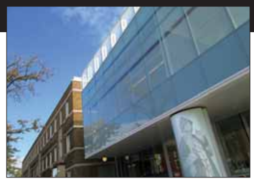
La façade de la bibliothèque Marc-Favreau, combinant l'édifice existant à la nouvelle construction et intégrant la colonne à l'effigie de Sol.
