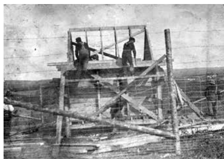
Construction d'une poudrière, utilisée pour conserver les explosifs, souvent essentiels pour « libérer » le passage ! Septembre 1905.
