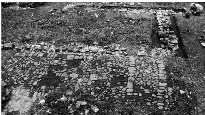
Chantier de fouille de l'habitation d'Anglemont
