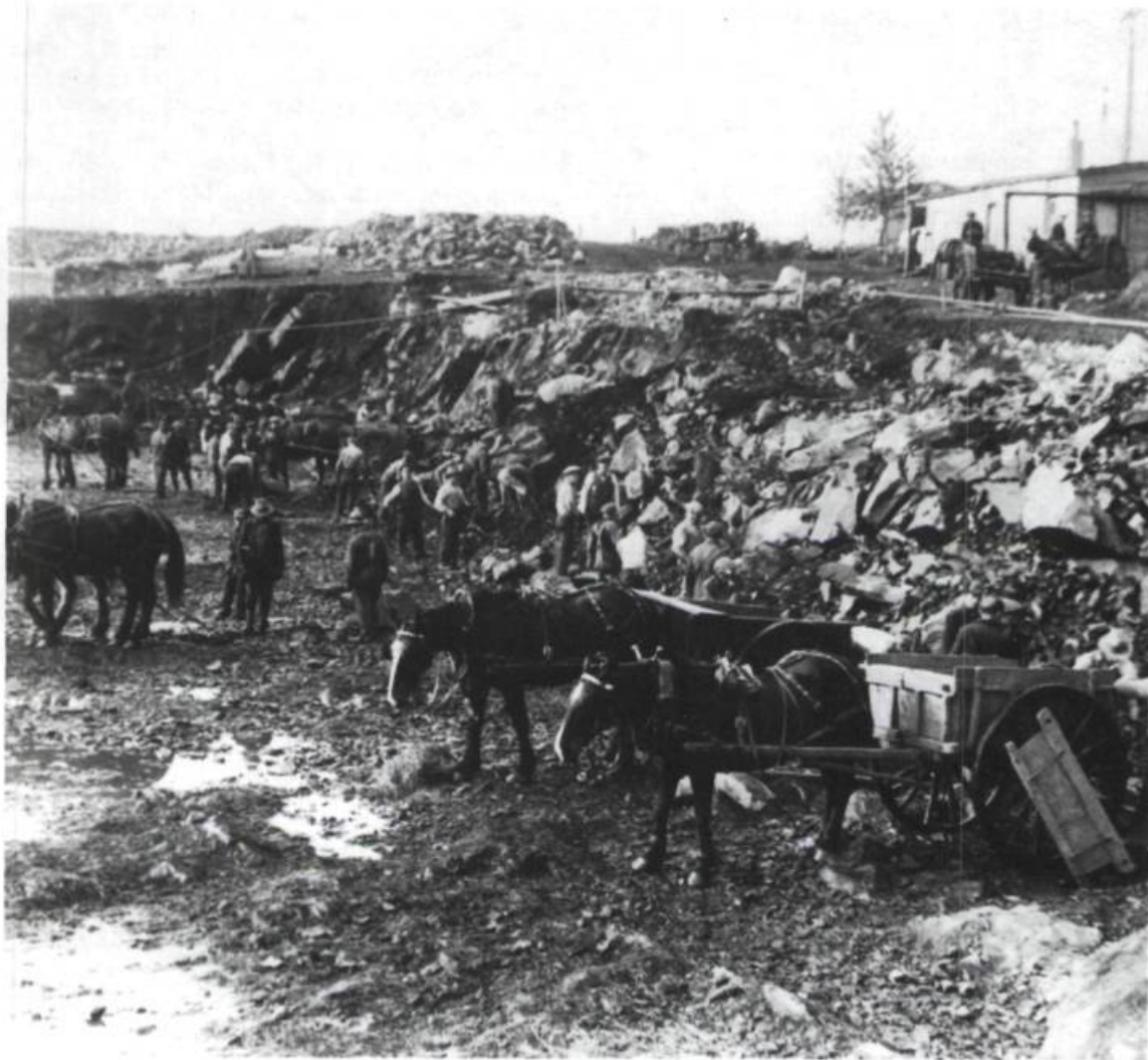
Pour combattre le chômage durant la crise, la ville de Québec entreprend de grands travaux. La construction du réservoir de l'aqueduc sur les Plaines d'Abraham en 1931. Archives de la ville de Québec.
