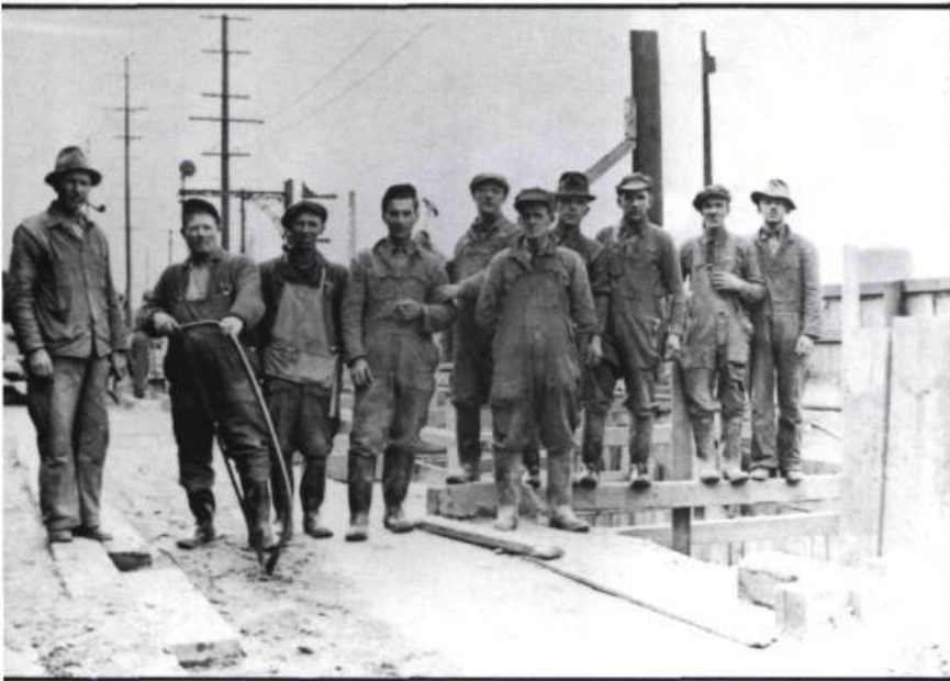
Groupe de travailleurs affectés à la construction de l'égout collecteur dans la décennie 1930. Archives de la ville de Québec.
