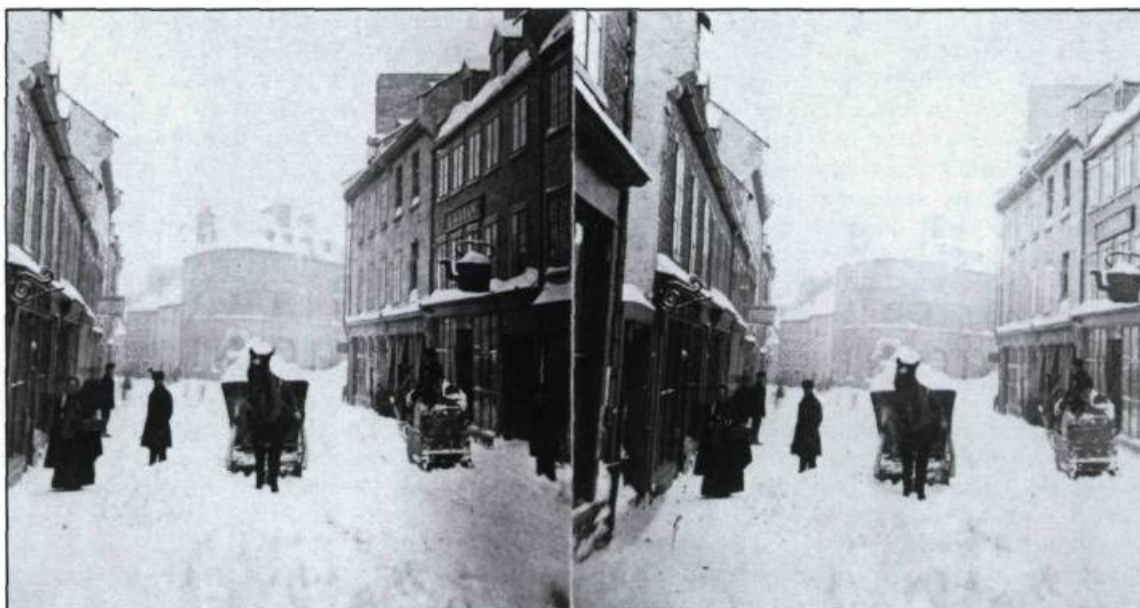
Séréogramme de 1870 illustrant une scène de déneigement au lendemain d'une tempête. En arrière-plan, l'édifice Livernois situé à l'encoignure des rues Couillard et Garneau. (Collection de l'auteur).
