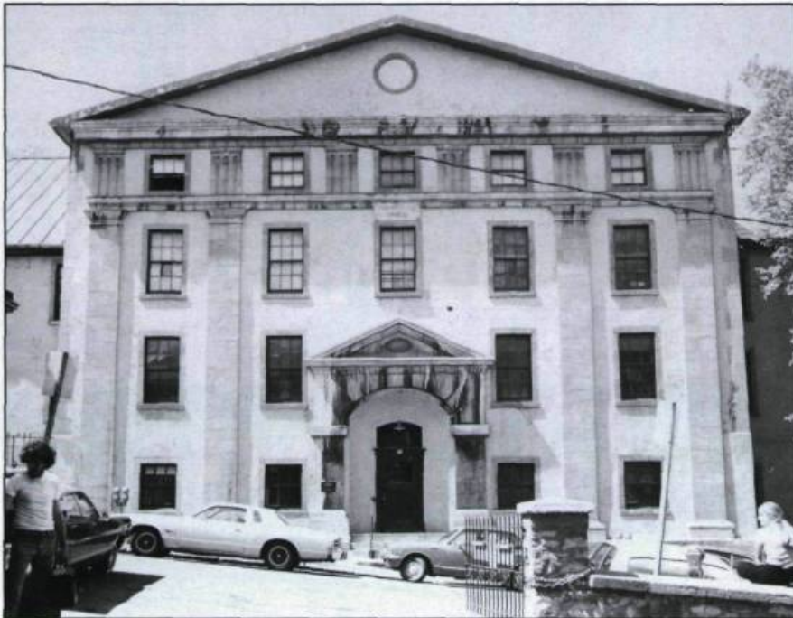
Construit de 1808 à 1814, d'après les plans de François Baillairgé, cet édifice a d'abord abrité la prison de Québec. En 1866, les gouverneurs du Morrin College l'acquièrent pour y loger leur collège. (Ministère des Affaires culturelles).
