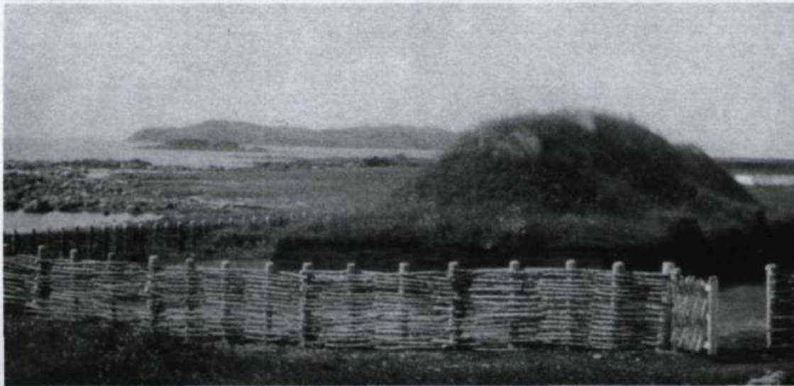
«Reconstruction d'une habitation viking à l'Anse aux Meadows». La maison viking est très simple : il s'agit d'une charpente en bois, sans fenêtres, recouverte de tourbe. Le site du village, maintenant un lieu du patrimoine mondial, est à l'arrière-plan. (Photo. Parcs Canada).
