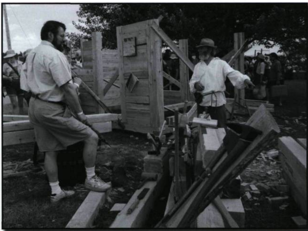
Gaétan Pilon, artisan, construisant une petite maison pièce sur pièce à tenon en coulisse. (Collection Festival des Vieux-Métiers).
