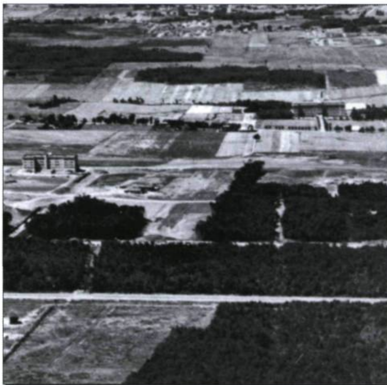
En septembre 1945, le Séminaire de Québec se porte acquéreur d'un immense terrain appartenant aux Frères des Écoles chrétiennes sur les hauteurs de Sainte-Foy. En 1946, commence la construction du pavillon de la Faculté de foresterie et de géodésie. (Division des archives de l'Université Laval).
