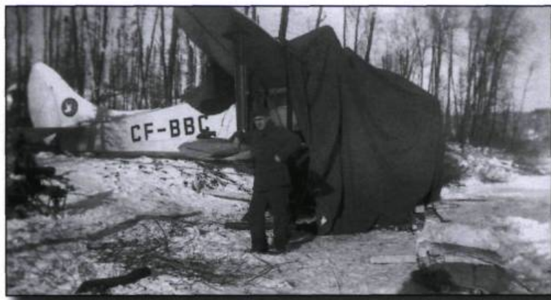
■ Lucien Gendron. En hiver, on recouvre le nez de l'avion d'une bâche pour le protéger des intempéries ou pour effectuer des réparations. (Collection M me Françoise Gendron).
