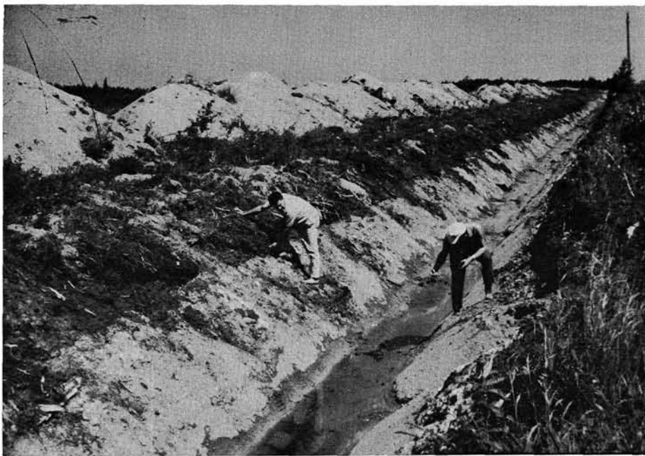
Photo 2 Drainage artificiel. Canton de Berry.
