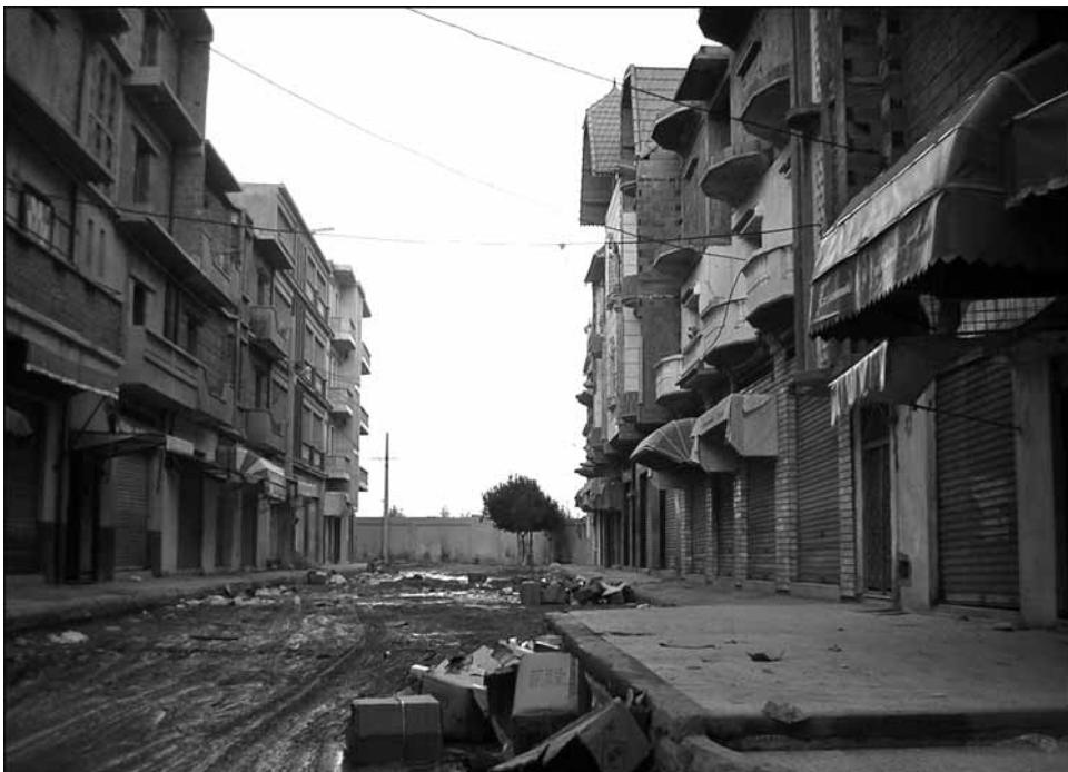
Figure 5 Villas-immeubles à usage commercial en fin de journée (El Eulma)
