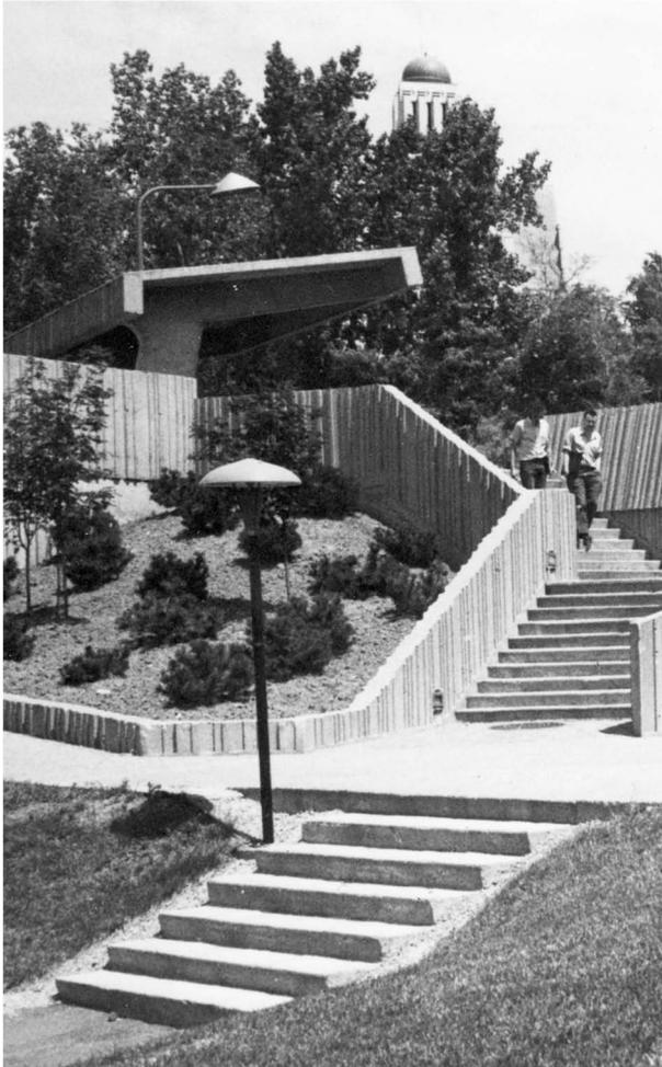
L'utilisation du béton texturé est notable dans les ouvrages réalisés par La Haye et associés dans les années 1960. Ce passage le long du pavillon Samuel-Bronfman en est un exemple.
