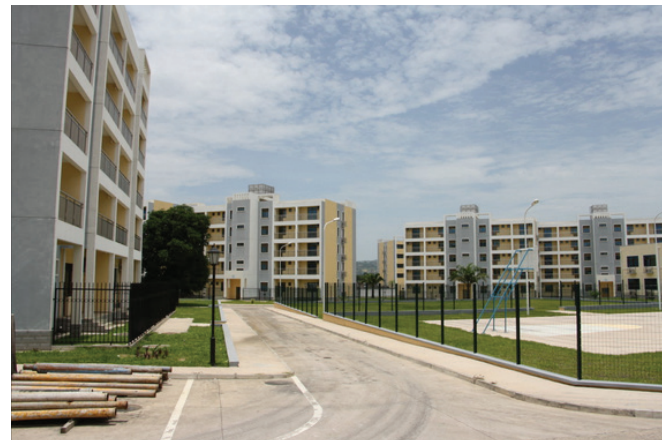
PHOTO 1a et 1b Logements sociaux de Mpila et du camp Clairon
