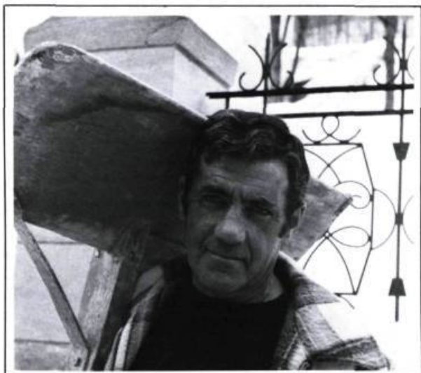
Alfred Abel portant l'oiseau, instrument servant au transport du plâtre.
