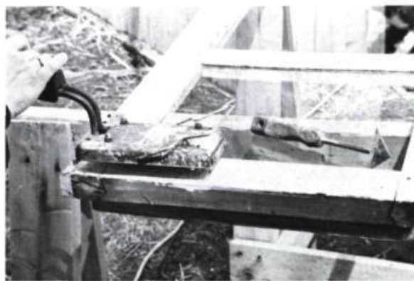
G L'utilisation du fer à élément chauffant simplifie et facilite le décapage lorsqu'il faut mettre le bois à nu avant de repeindre.
