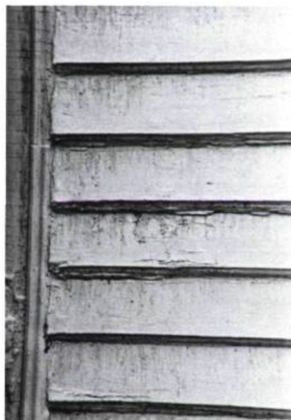
H Une trop grande accumulation de couches de peinture rend parfois difficile la lecture de la mouluration et l'appréciation des détails architecturaux. Il faut questionner la nécessité de toute nouvelle couche de peinture.
