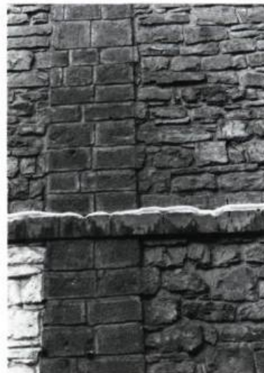
13 Le bandeau horizontal et la jambe, éléments de décor qui expriment l'harmonie et la symétrie de la composition architecturale de l'édifice.
