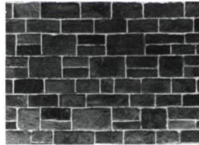
6 Appareil réglé: cet appareil se distingue de l'appareil assisé par la régularité de la hauteur des pierres d'une même assise et par la continuité des assises.
