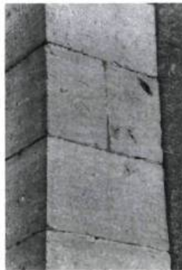
3 Exemple de pierres d'un pilastre taillées et dressées ou finies au ciseau. Les bordures sont ciselées ou layées de même que l'ensemble de chacune des faces apparentes. Le maçon y a laissé des marques pour appareiller certaines pierres entre elles.
