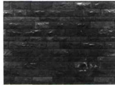
7 Appareil à alternance d'assises régulières: la hauteur des assises varie en alternance.
