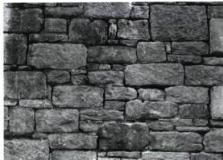
4 Appareil irrégulier où les pierres de grosseur variable et de forme irrégulière sont disposées librement sans alignement ou régularité.
