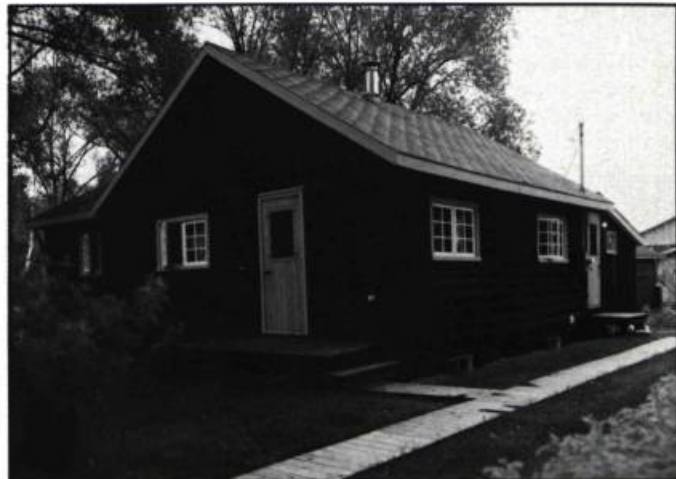
Une des maisons du Village minier, avant et après sa restauration rendue possible par les subventions du ministère des Affaires culturelles.
