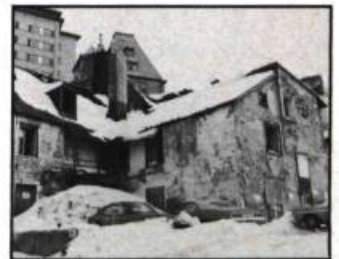
Les annexes (à droite) récemment démolies à l'arrière des maisons de Guise dit Flamand et McKenzie. (photo: Parcs Canada)
