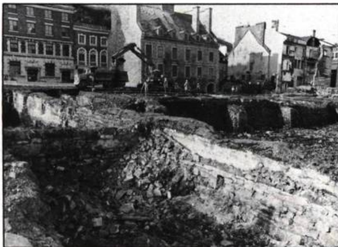
Les plus récents travaux à l'îlot Fargues, souvent faits sans surveillance archéologique, ont mis en danger des vestiges du Régime français. (photo: R. Marcoux)
