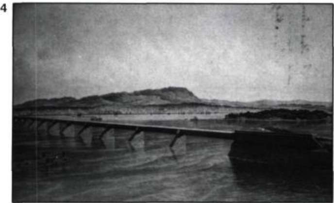
1. Les caissons flottants, montés sur de longues barges, étaient roulés puis vidés de leur eau afin de libérer l'espace pour les travaux de maçonnerie lors de l'érection des piles qui supportent les tubes du tablier. (lithographie couleur de S. Russel, d'après une photo de W. Notman, tirée de J. Hodges, Archives du port de Montréal)
