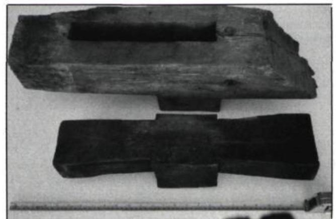
4. Illustration d'un sabot (en haut) et d'une clé (en bas) récupérés à la suite d'un curetage. Le sabot mortaisé reçoit l'extrémité du chevron et la clé taillée en double queue d'aronde retient entre elles les sablières. (photo: F. Varin)
