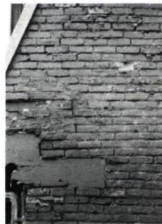
Un mur de brique recouvert de peinture cache souvent une brique de qualité inférieure.
