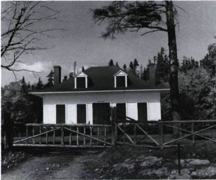
Rockwood, à Saint-Patrice-de-la-Rivière-du-Loup, un cottage qui illustre bien la transition entre la villa et le chalet d'été. (photo: B. Ostigey)
