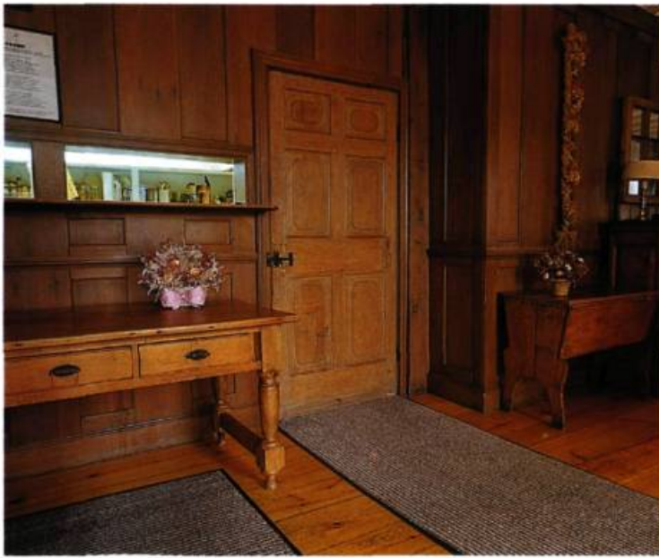
Une cloison faite de panneaux, principalement des anciennes portes, sépare la salle à manger des pièces de service. (photo: B. Ostiguy)
