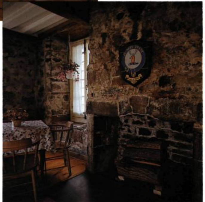
Même si à l'origine ils étaient sans doute grossièrement plâtrés, les murs ont été mis à nu pour révéler la richesse de la maçonnerie. Des feuilles de plexiglas, à la base du foyer, laissent apparaître les pierres de l'âtre originel. (photo: B. Ostiguy)
