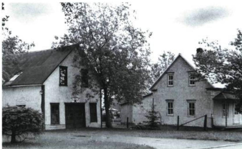
L'ancienne boutique de forge. (photo: Continuité)
