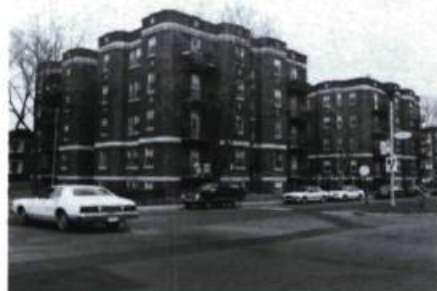
Immeuble The Tiber, 1521-1539, Bernard (Perrault & Gadbois, arch.; 1928). Photo: P.-R. Bisson et Ass.
