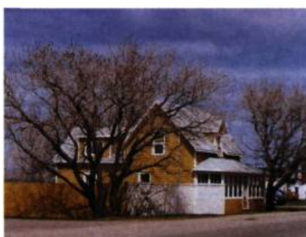
Souvent construite en bardeaux, la maison acadienne résiste au climat maritime.
