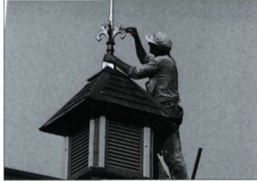
Bel épi de tôle surmontant un lanternon d'écurie. Photo : François Varin
