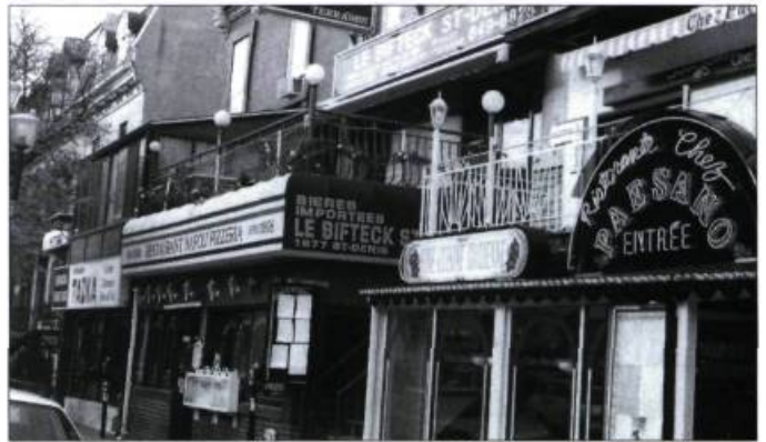
La rue Saint-Denis à Montréal. Les avancées ont occulté l'architecture traditionnelle.
