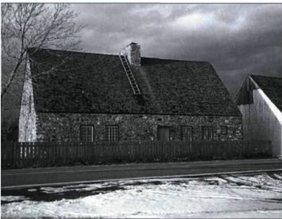
Les maisons d'« esprit français » sont encore nombreuses dans les six paroisses de l'île. Ces constructions se caractérisent, entre autres, par un toit aigu et par l'absence de rive et de larmiers. Photo : Luc-Antoine Couturier
