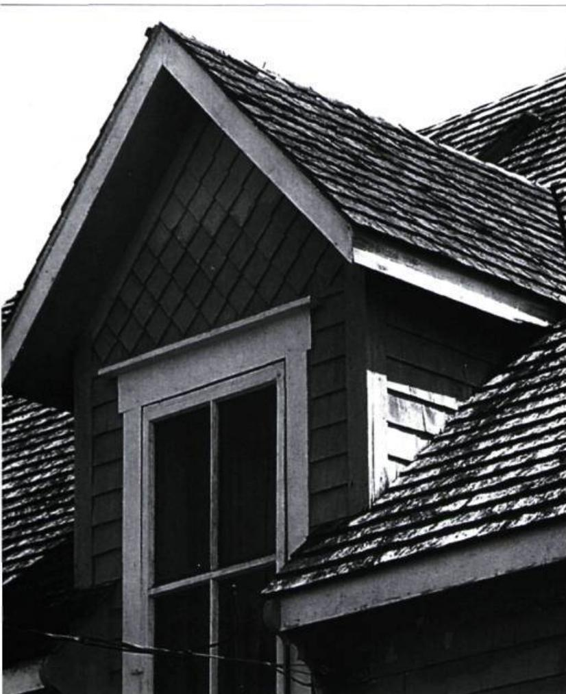
Aspect général d'un pan de toiture exposé au soleil : la surface extérieure des bardeaux mal taillés sèche plus rapidement, et ces derniers se courbent.
