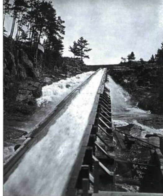
Le gouvernement du Canada-Uni accorde 20 000 $ en 1852 pour la construction d'estacades et d'une glissoire à billes permettant aux billes de bois de franchir les chutes de Shawinigan.
