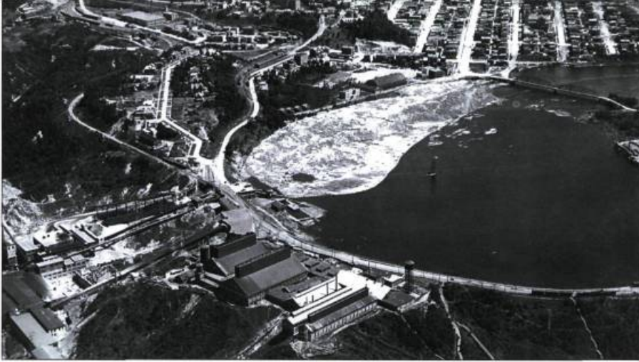
Vue aérienne de 1918 du bastion industriel formé par la Northern Aluminium Co. et la Belgo. Jeune d'à peine 20 ans, le quartier de la Pointe-à-Bernard s'avance au creux d'un méandre de la rivière Saint-Maurice. Photo : Centre d'interprétation de l'industrie de Shawinigan
