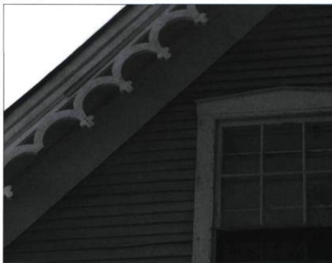
Détail d'un beau clin de bois, de faible hauteur (environ 7,5 cm), qui vient buter contre une planche de frise sous la corniche.
