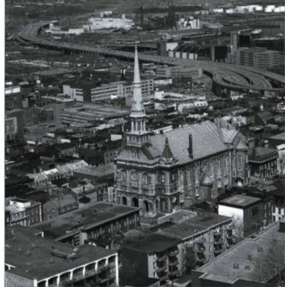
Au cours des dernières années, des sommes importantes ont été investies dans la restauration de l'église Saint-Jean-Baptiste de Québec.
