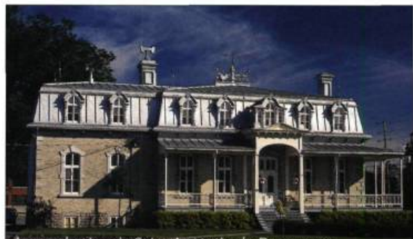
Le presbytère de Saint-Augustin-de-Desmaures fait partie d'un ensemble patrimonial prestigieux au cœur de la municipalité.
