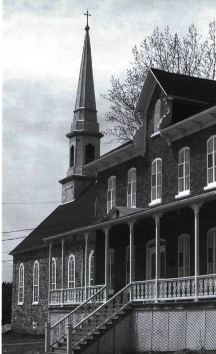
Dans le noyau villageois de Saint-Fidèle, on retrouve une concentration de bâtiments en bois d'avant 1940 et un ensemble religieux (presbytère, église et enclos paroissial) fort intéressants.
