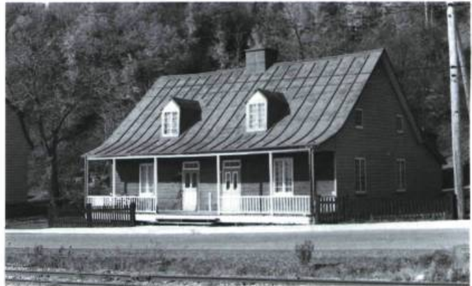
La maison Tremblay-Patterson à Beauport est une maison jumelée en bois qui possède une structure en madrier « sur le cant » (un matériau produit par la scierie Patterson) et une cheminée centrale à foyer double.
