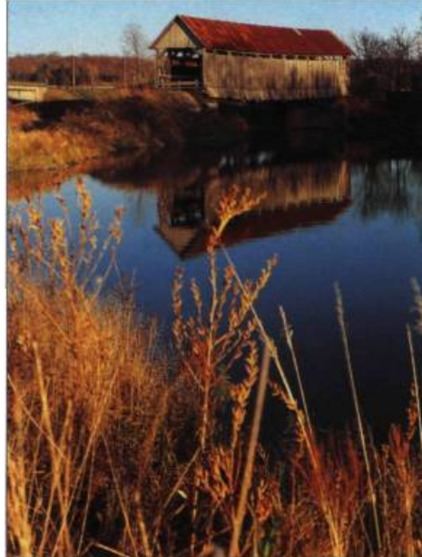
Le pont Drouin (1886) sur la rivière Coaticook à Compton Station est l'un des trois derniers ponts à poinçons multiples au Québec. Son lambris vertical sans ouverture est également un élément d'intérêt. Menacé de démolition, il a été sauvé in extremis par un comité de sauvegarde local. Photo : Jocelyn Boutin
