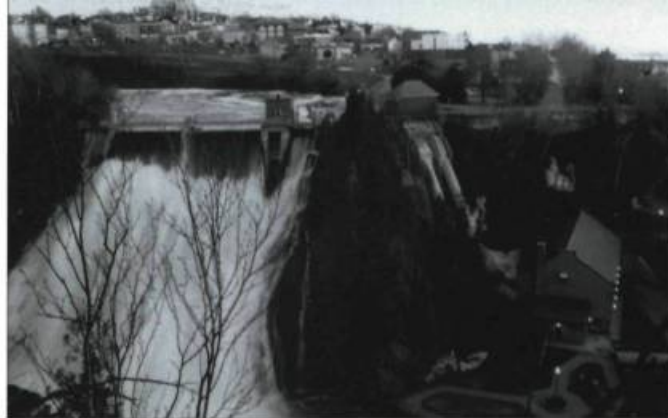
Au Parc des chutes, la restauration et la remise en fonction de l'ancienne centrale hydroélectrique constituent un précédent dans la conservation et la mise en valeur du patrimoine industriel du Bas-Saint-Laurent.
