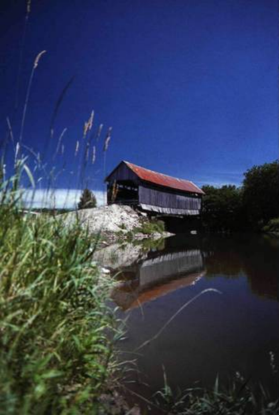
Le pont Milby près de Waterville, l'un des nombreux ponts couverts de l'Estrie, attrait indéniable du patrimoine régional.
