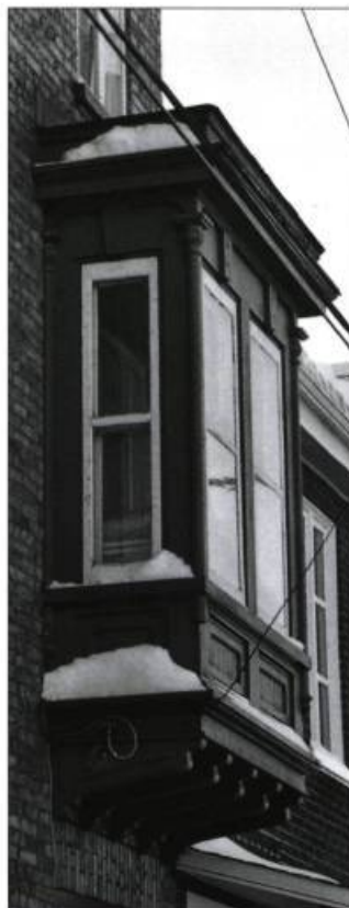
L'oriel repose ici sur des équerres de bois.
