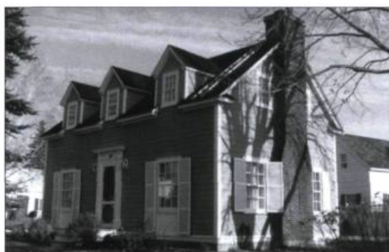
Une maison de L'Isle-Maligne aujourd'hui.
